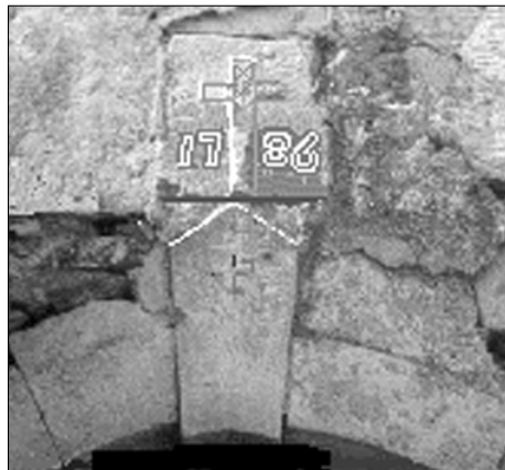
Το Υπέρθυρο στην είσοδο της τραπεζαρίας του νέου υποσυγκροτήματος (ιδιοκτησίας Ραπτοπουλαίων) με την ημερομηνία ανεγέρσεως 1786
